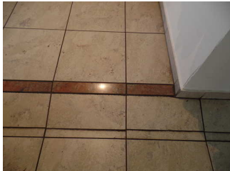
Schwelle vor Toilette
